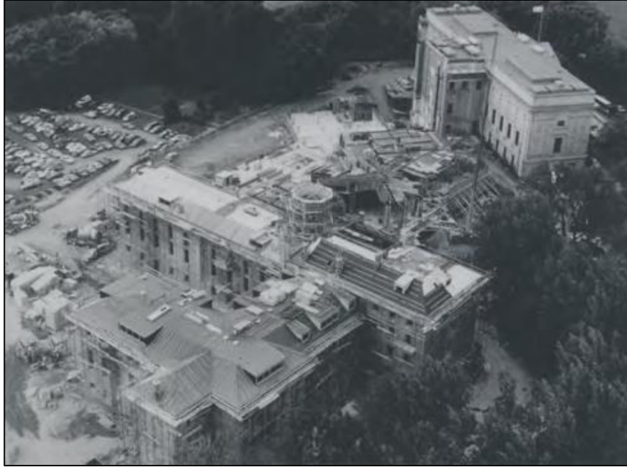
FIGURE 14: SITE DE L'ANNEXE ARRIÈRE (DÉMOLIE), PHOTOGRAPHIÉ LE 7 JUILLET 1989. (MNBAQ, ARCHIVES INSTITUTIONNELLES, BERGERON ET GAGNON 2019 : 62).
