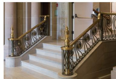
Parmi les nombreuses actions réalisées, mentionnons la réfection des murs de maçonnerie intérieurs et des planchers de marbre et de granite des trois niveaux. L'escalier a aussi été remis en valeur par la restauration des mains courantes de bois et des garde-corps en laiton et en fer forgé, ainsi que par l'élimination des cloisons cachant la volée d'escalier.
