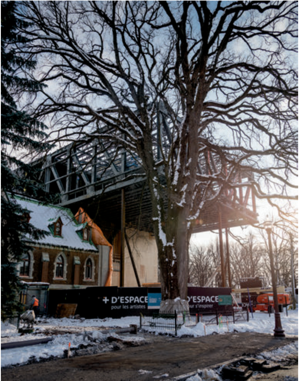
Le chantier du nouveau pavillon en novembre 2014.
